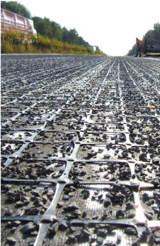
Abb. 6: Tensor AR-G nach der Absplittung
