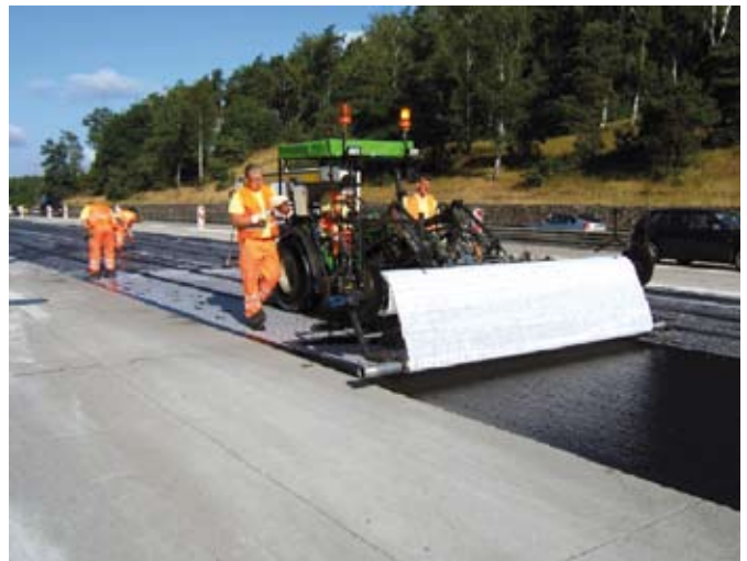
Abb. 5: Maschinelle Verlegung der Asphalteinlage
