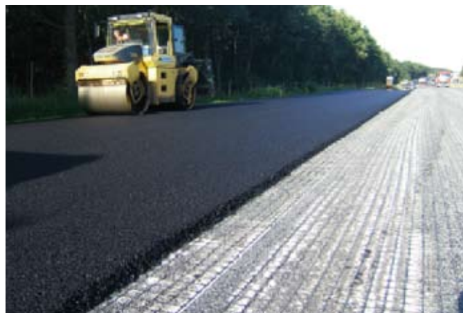
Abb. 7 und 8: Einbau und Verdichtung der Binderschicht
