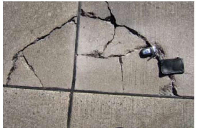
Abb. 2: Verschotterungen an den Fugenkreuzen, Schadenskategorie III
