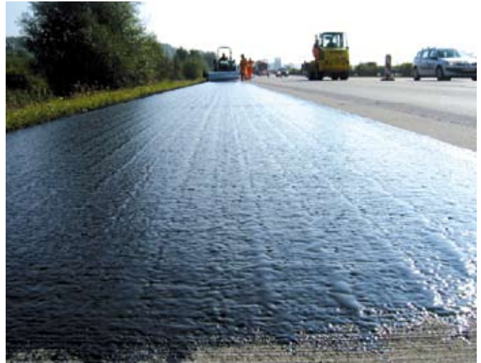
Abb. 4: Aufgebrachte Bitumenemulsion
