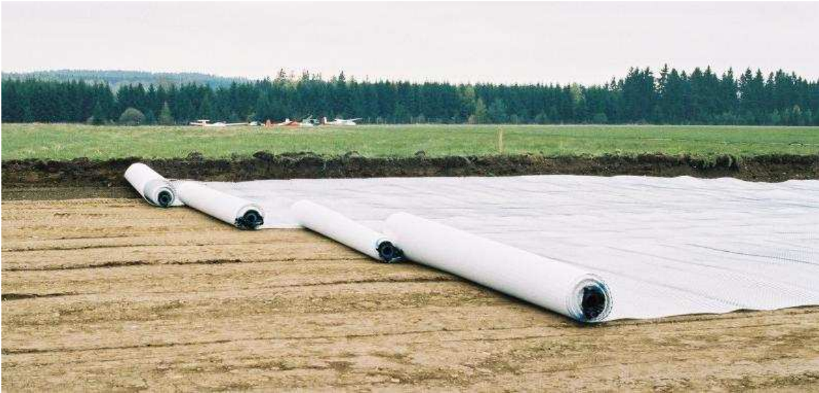
Erweiterung Flugplatz Dahlemer Binz: Befestigung von Sicherheitsflächen
