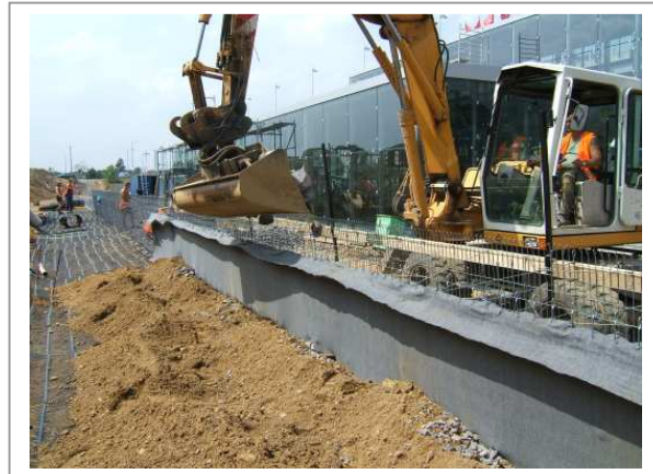
Bild 2: Herstellung der Gabionen
