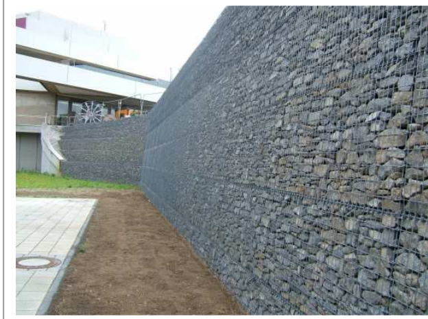
Bild 1: Ansicht der fertig gestellten Gabionenwand
