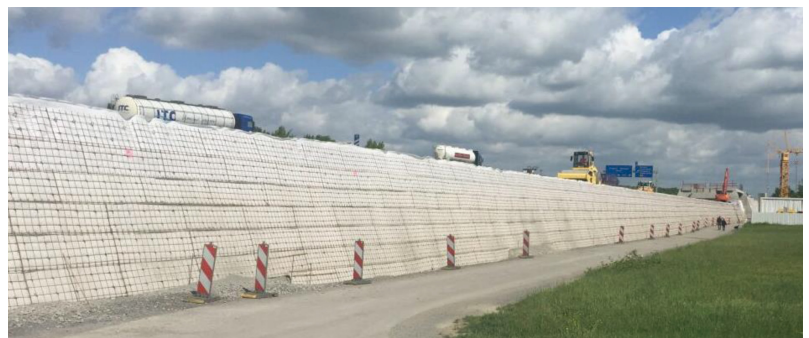
Bild 1: Im Bau befindliche Umfahrung bei fließendem Verkehr auf der BAB 5 im Hintergrund
