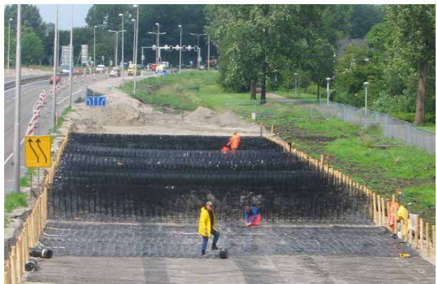
Bau des Systems TensarTech Stratum als Dammgründung
