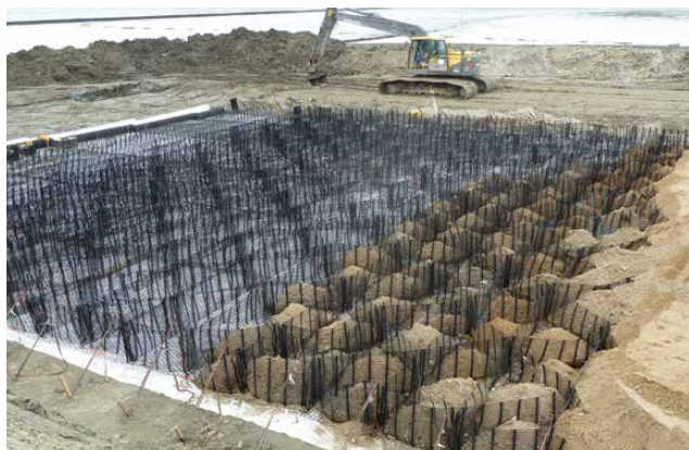
Bau des Systems TensarTech Stratum als Gründung für den Deich
