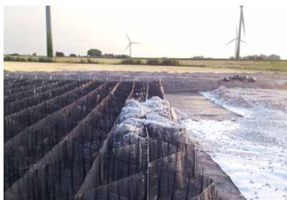
Aufgebautes System TensarTech Stratum vor Verfüllung mit RC-Material
