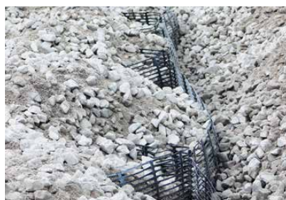
Eingebautes System TensarTech Stratum nach Verfüllung mit RC-Material
