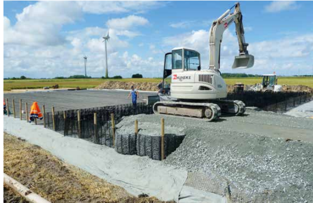
Bau des Systems TensarTech Stratum als Kranstellfläche
