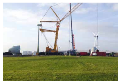
Kranstellfläche in Betrieb
