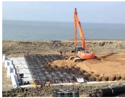
Sofort nach Einbau befahrbares System TensarTech Stratum
